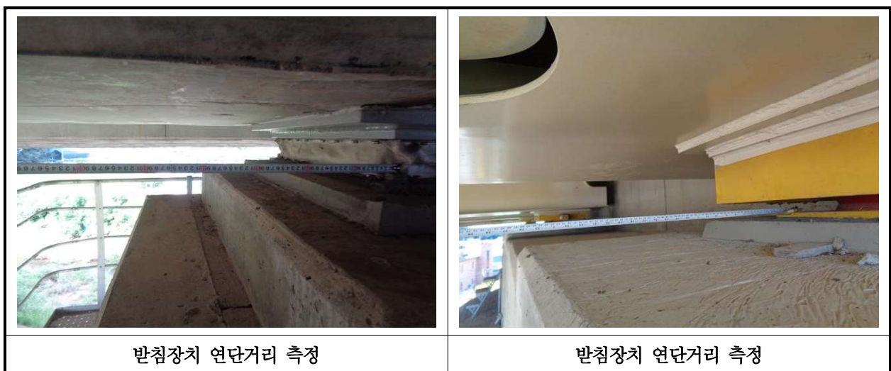
【사진 28.3.14】 교량받침장치 연단거리측정
