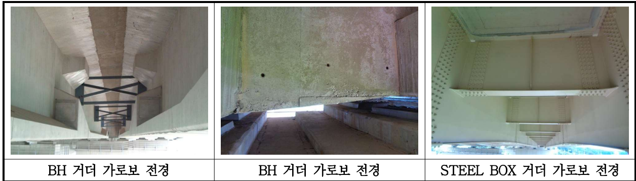
【사진 28.3.6】 가로보 전경
