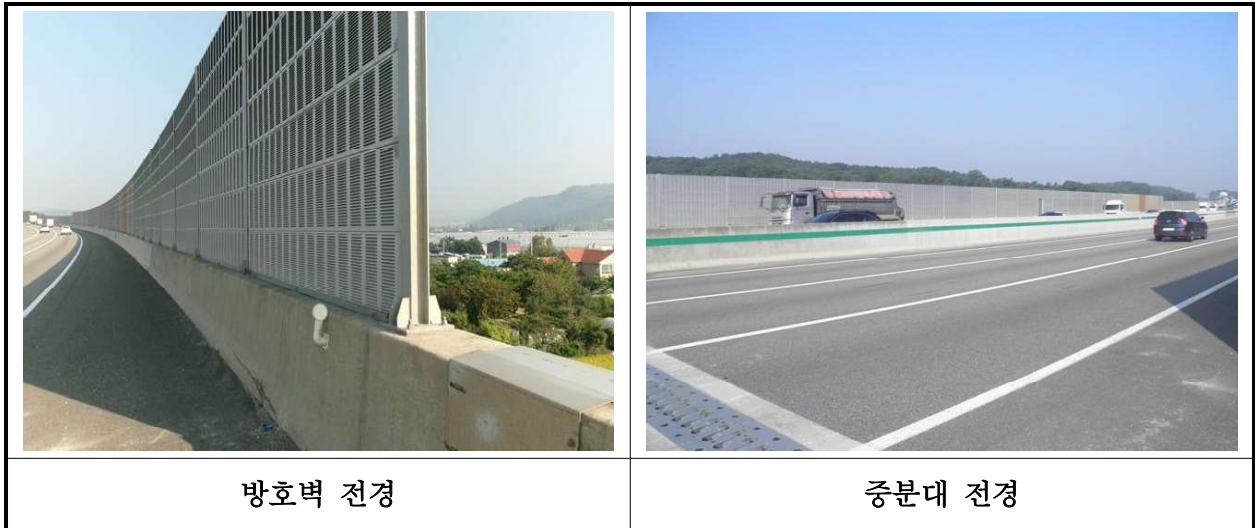
【사진 28.3.23】 방호벽 및 중앙분리대 전경
