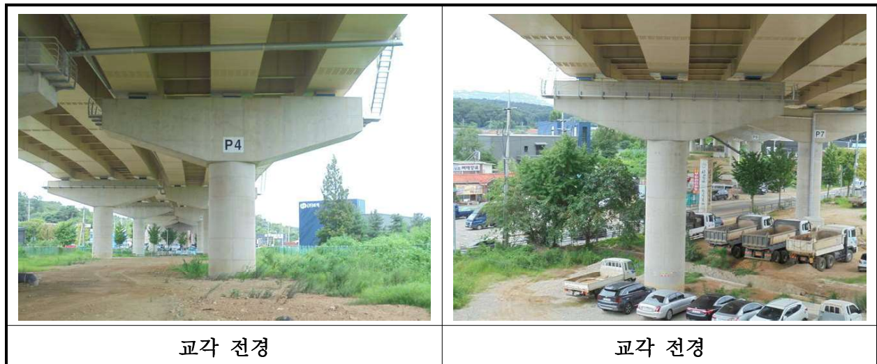
【사진 28.3.10】 교각 전경
