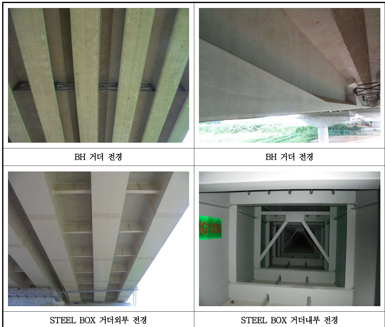
【사진 28.3.4】 거더 전경
