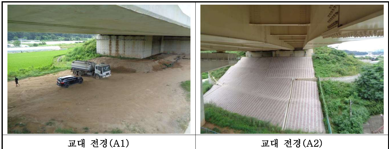
【사진 28.3.8】 교대 전경
