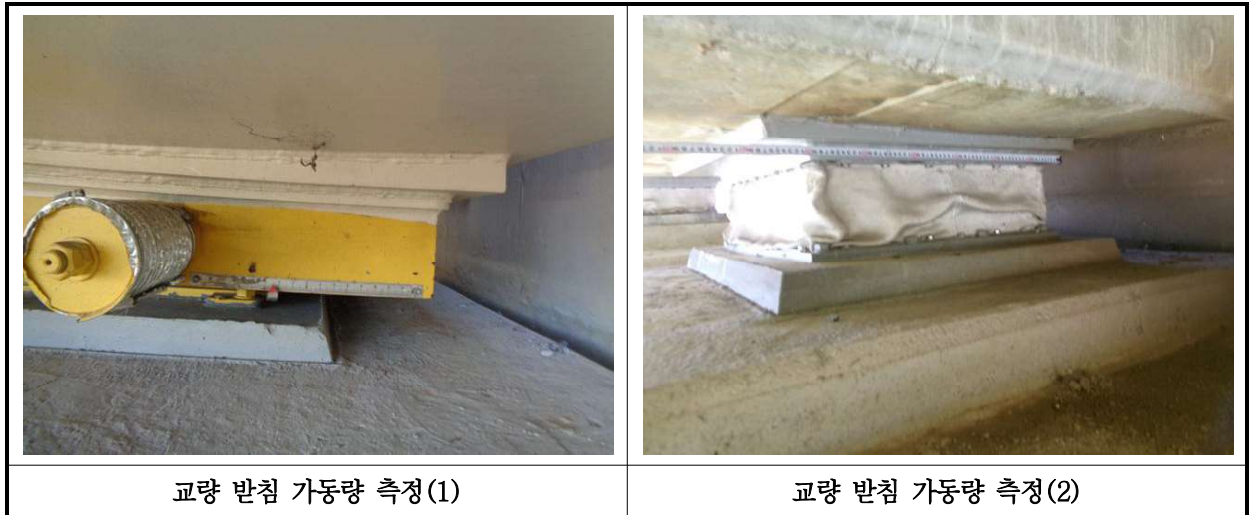
【사진 28.3.15】 교량받침 이동량 측정
