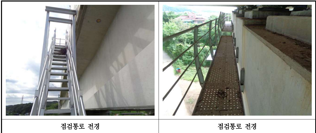
【사진 28.3.25】 교량 점검시설 전경
