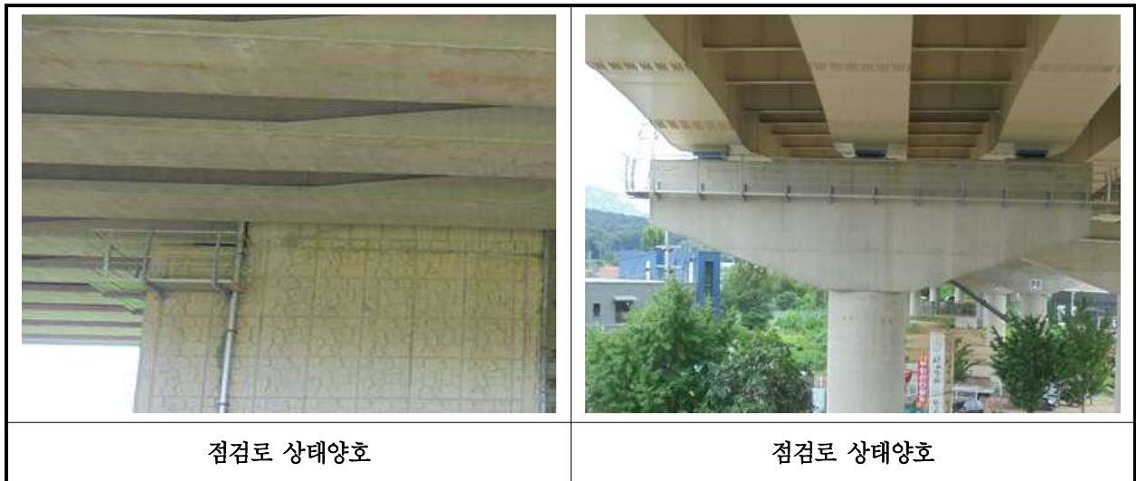
【사진 28.3.26】 교량 점검시설 손상현황
