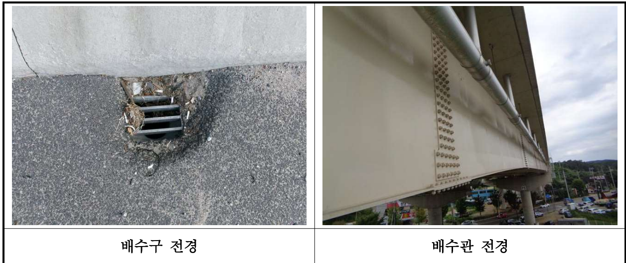
【사진 28.3.21】 배수시설 전경
