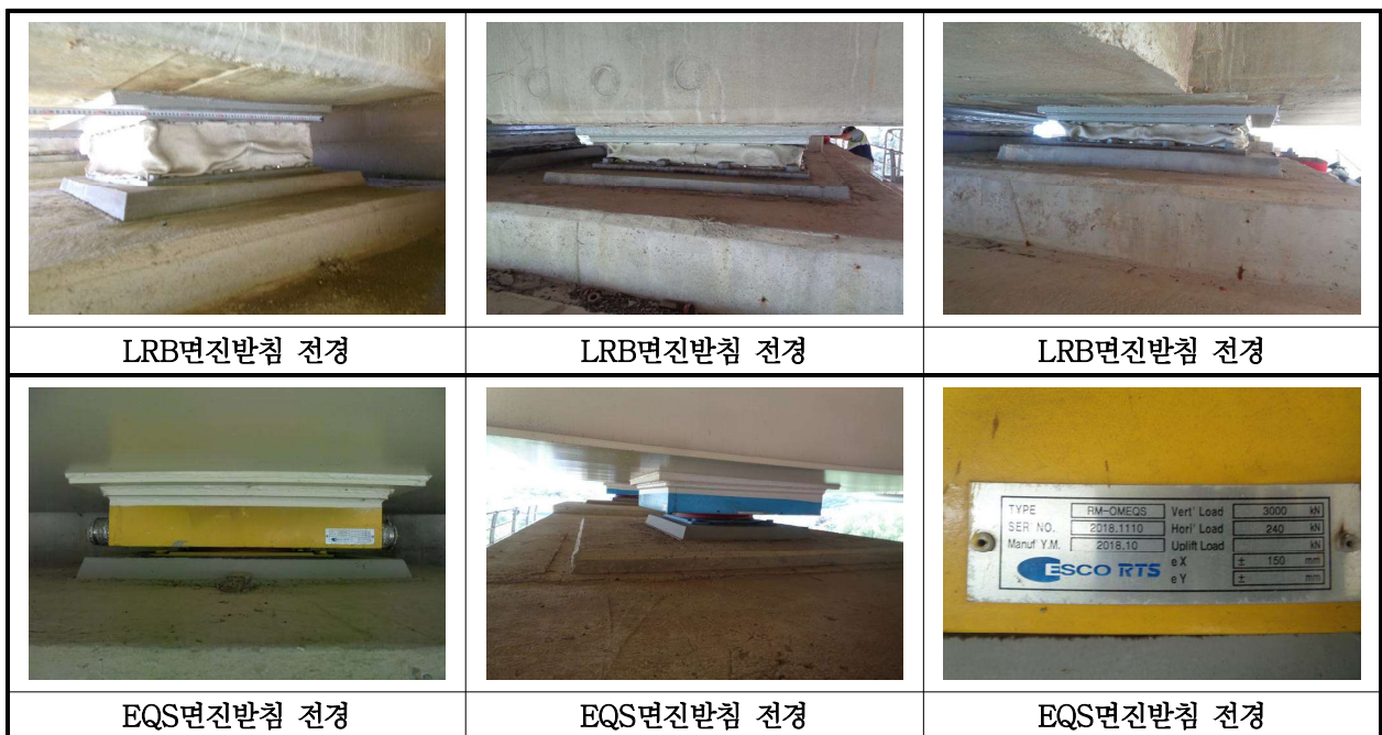
【사진 28.3.12】 교량받침 전경
