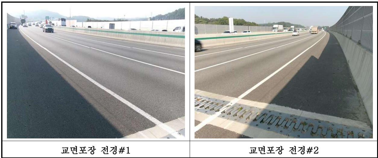
【사진 28.3.19】 교면포장 전경
