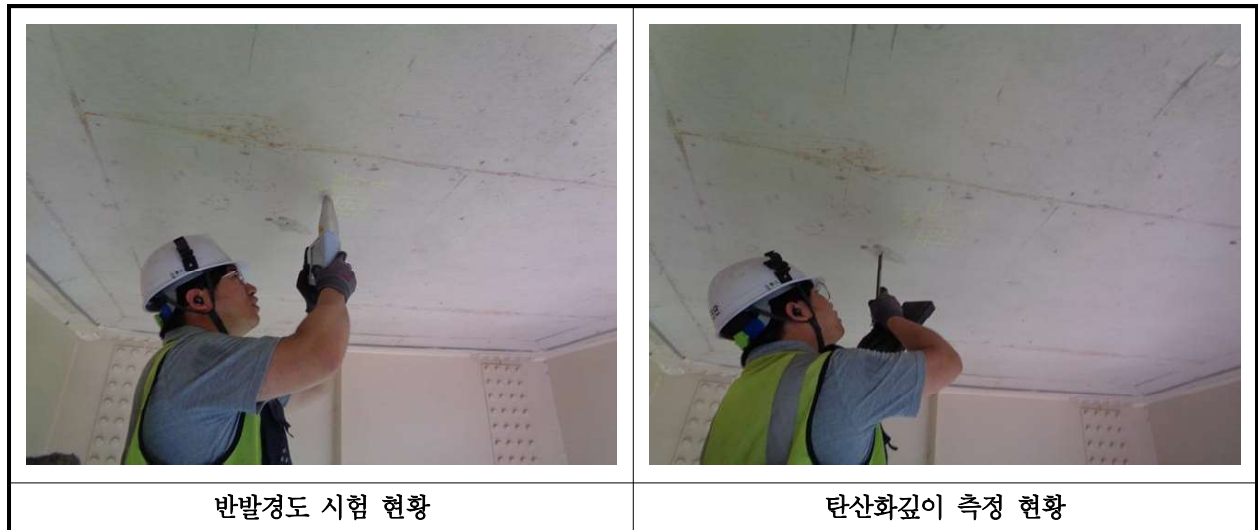
【사진 28.4.1】 콘크리트 내구성조사 현황
